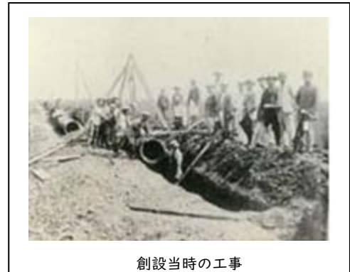
創設当時の工事
