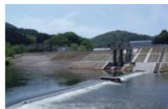
取水ぜき（ラバーダム）
