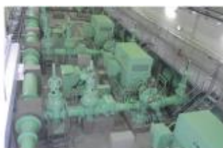
導水ポンプ 18.2 \text{ m}^3 / \text{min} \times 500 \text{kw} \times 3 \text{台}
