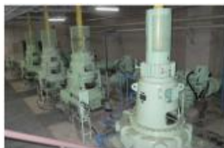
導水ポンプ 19.1 \text{ m}^3 / \text{min} \times 515 \text{kw} \times 4 \text{台}
