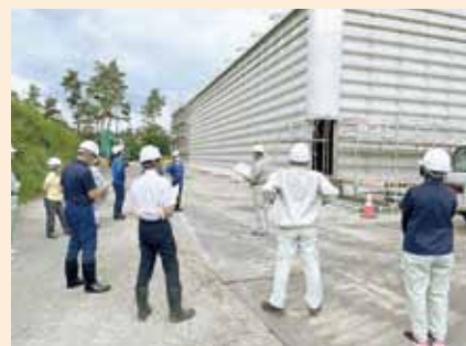
▲瀬戸配水池築造工事現場を視察
