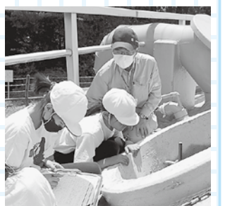
▲御代田高地区配水池(浄水場敷地内)の点検口からタンク内を見学
