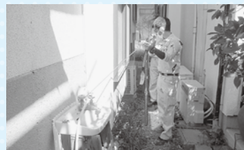
▲漏水調査の様子
