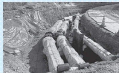
佐久市瀬戸では、新配水池建設に先立ち、周辺管路の布設（口径600mm）工事を施工しています。
