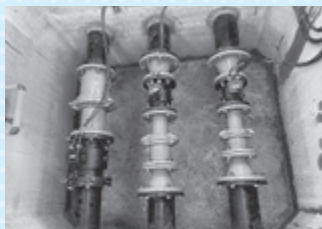
△場内地下ピットには、入水管、配水管、送水管それぞれに流量を把握するためのメータが設置されています。
