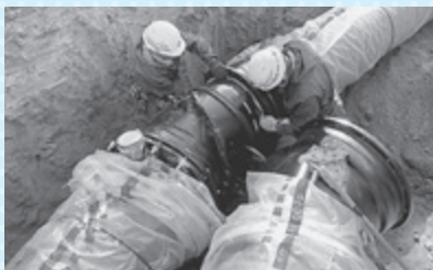
佐久市瀬戸では、新配水池建設に先立ち、周辺管路の布設（口径600mm）工事を施工しています。
