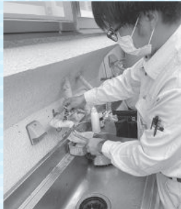
▲蛇口を閉めても水が垂れるため蛇口内のパッキンを交換。依頼された方からは水漏れが解消され、とても安心していました。
