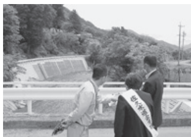
▲災害復旧箇所の視察
