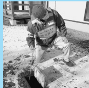
▲漏水調査をしている様子
