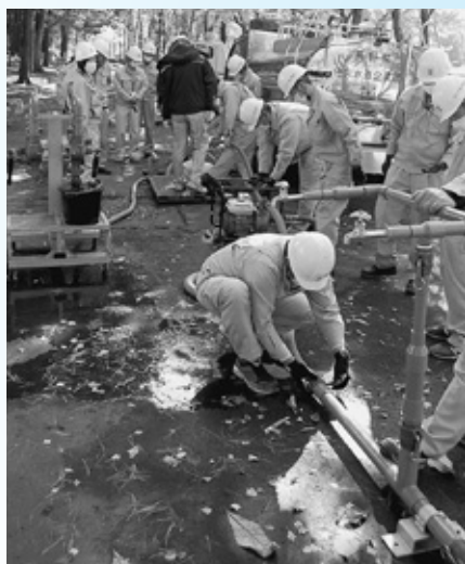
▲貯水槽の水を給水するため管を接続している様子
