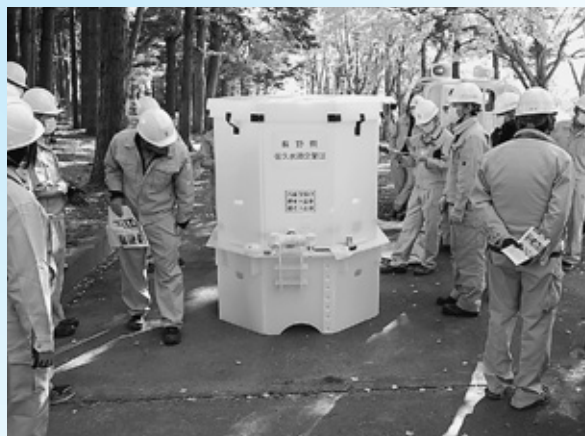
▲非常用給水タンク（容量 1.0 m 3 ）の組立状況
