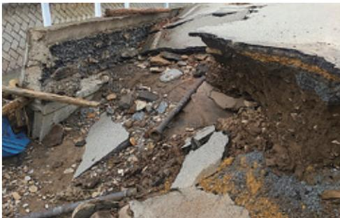
配水管が露出し、継手が離脱
