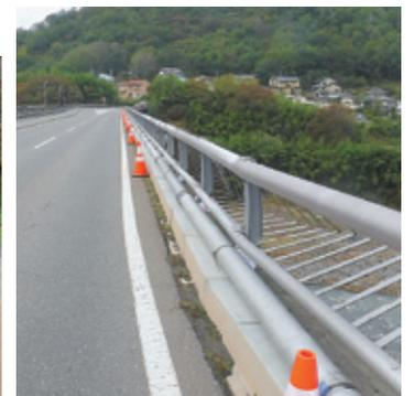
御八城橋欄干に設置した仮設配管
