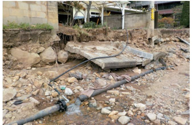
離脱した配水管に給水管で仮設配管
