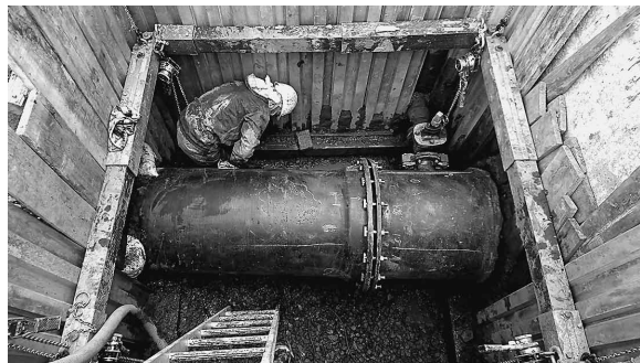
▲昭和51年に布設された口径700mmのダクタイル鋳鉄管
