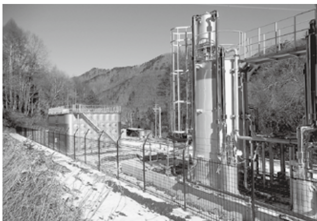
↑左が配水池 右がろ過機
