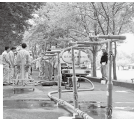
↑貯水槽から給水車への取出しや使用できるように蛇口を設置している模様
