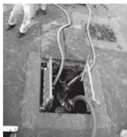
↑貯水槽から給水車への取出しや使用できるように蛇口を設置している模様
