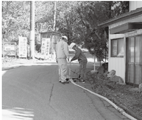
▲断水時消火栓からの水抜き作業
