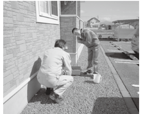
▲漏水を調査している様子
