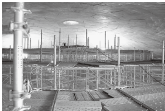
↑配水池内から撮影した天井の様子（工事のため足場が組まれています。）
