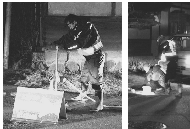
▲消火栓から排水する作業の様子
