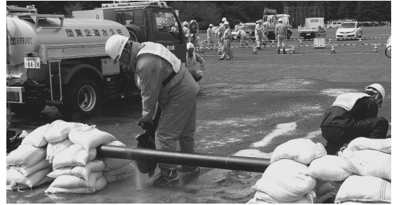
▲水道施設復旧訓練の様子
