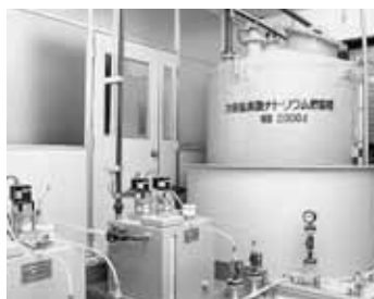
▲次亜塩素酸ナトリウム注入機
