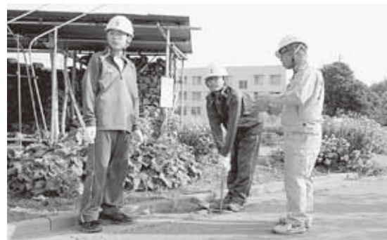
▲工事現場で通水作業を経験している様子
