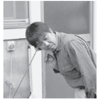
▲熟練の技術で漏水箇所を調査
