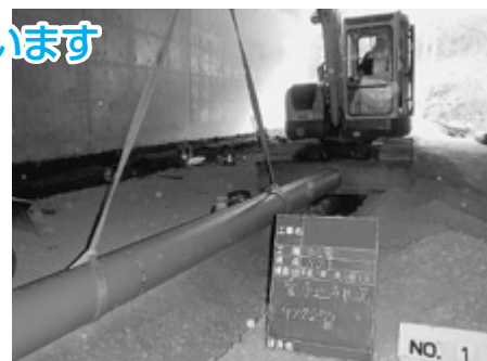
▲ 水道管耐震化工事の様子
