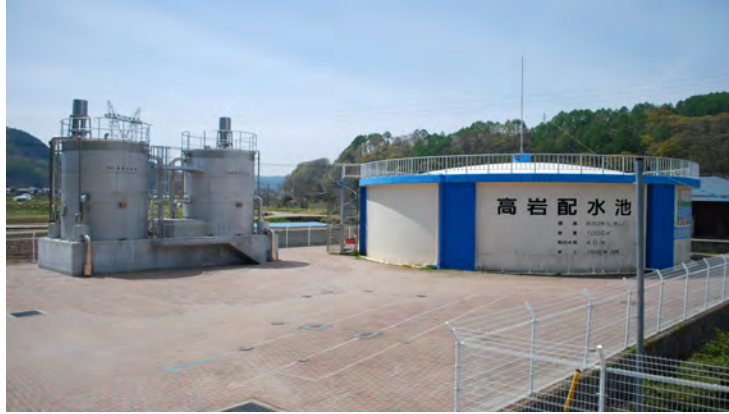
高岩浄水場（処理水量 2,660m 3 /日 急速ろ過機） 平成 26 年 4 月に完成した浄水場 浄水場で処理された水は、 高岩配水池から高岩、天神町、下海瀬地区へ給水している。
