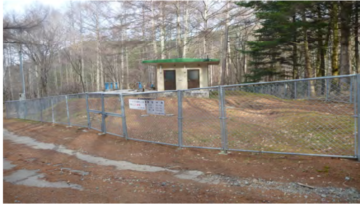
館向原簡易水道 館配水池（容量 102.0m 3 ）
