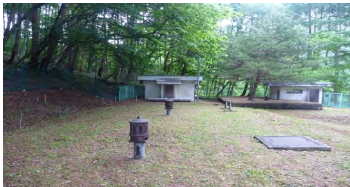
東地区簡易水道 都沢配水池（容量 355.9m 3 ） 平成 21 年 4 月に佐久穂町から移管された配水池 大日向地区へ給水している。
