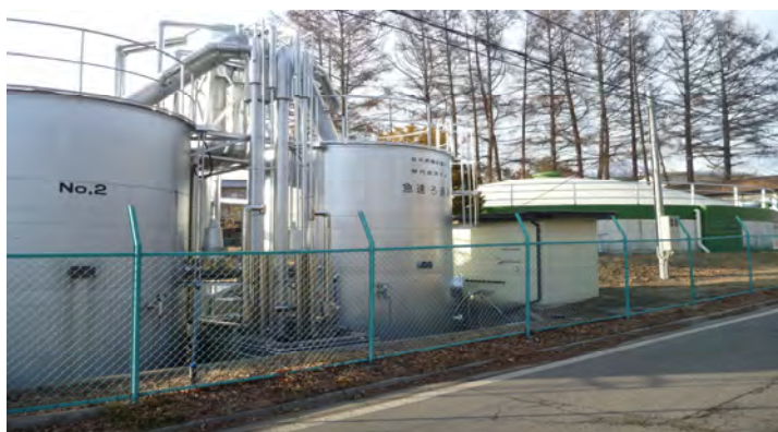
御代田浄水場（処理水量 1,600m 3 /日 急速ろ過機）
