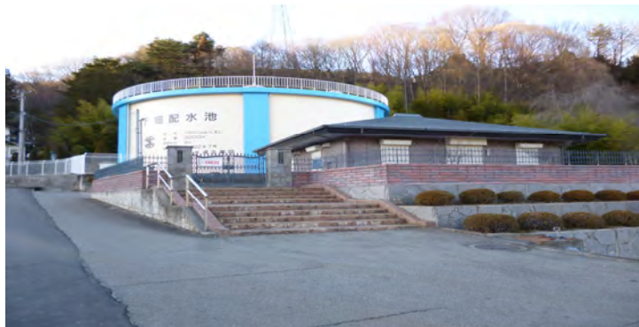
下畑配水池（容量 3,000m 3 ） 平成 4 年に建設された配水池 佐久穂町にある水源の水が集められ、佐久市へ給水している。
