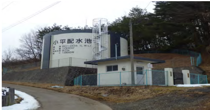
小平配水池（容量 1,000m 3 ）
