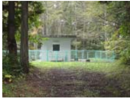
以前合併した旧望月町にある 合の沢配水池
