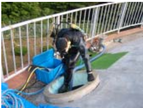
ダイバーによる配水池内部の 点検作業。
